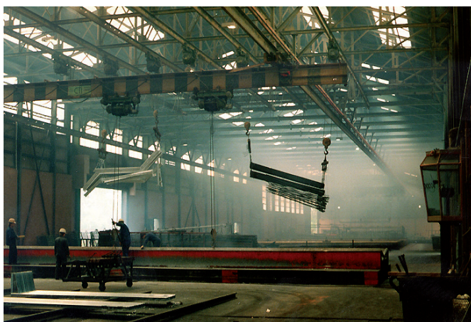
Versorgung und Steuerung von Brückenkränen in einer Verzinkerei.
