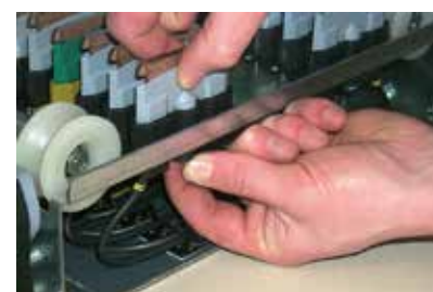
Remplacement des balais à blocs de charbon
