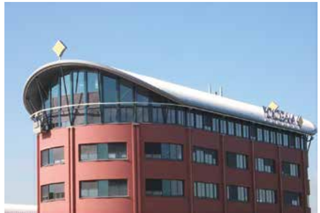
Installatie met bochten ten behoeve van gevelreiniging
