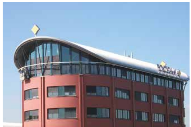
Installatie met bochten ten behoeve van gevelreiniging
