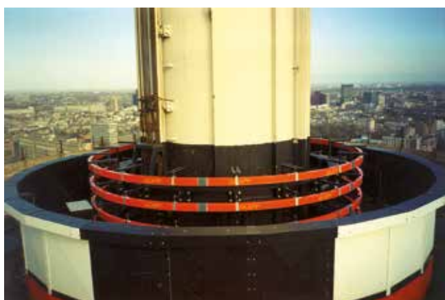
Quatre convoyeurs circulaires pour alimenter un ascenseur rotatif.
