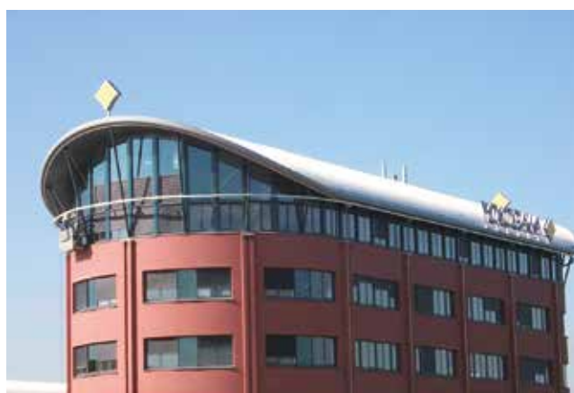
Installation à des courbes pour le ravalement de façades
