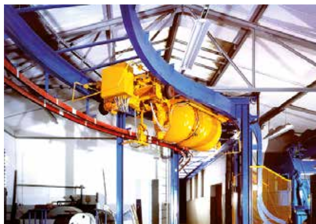
Alimentation et manèment d'une installation de benne à béton.
