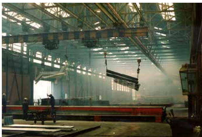
Alimentation et manèment d'un pont roulant dans un atelier de galvanisation.
