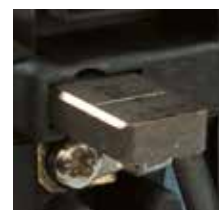
L'inspection visuelle des balais à charbon est très simple grâce au marquage.
