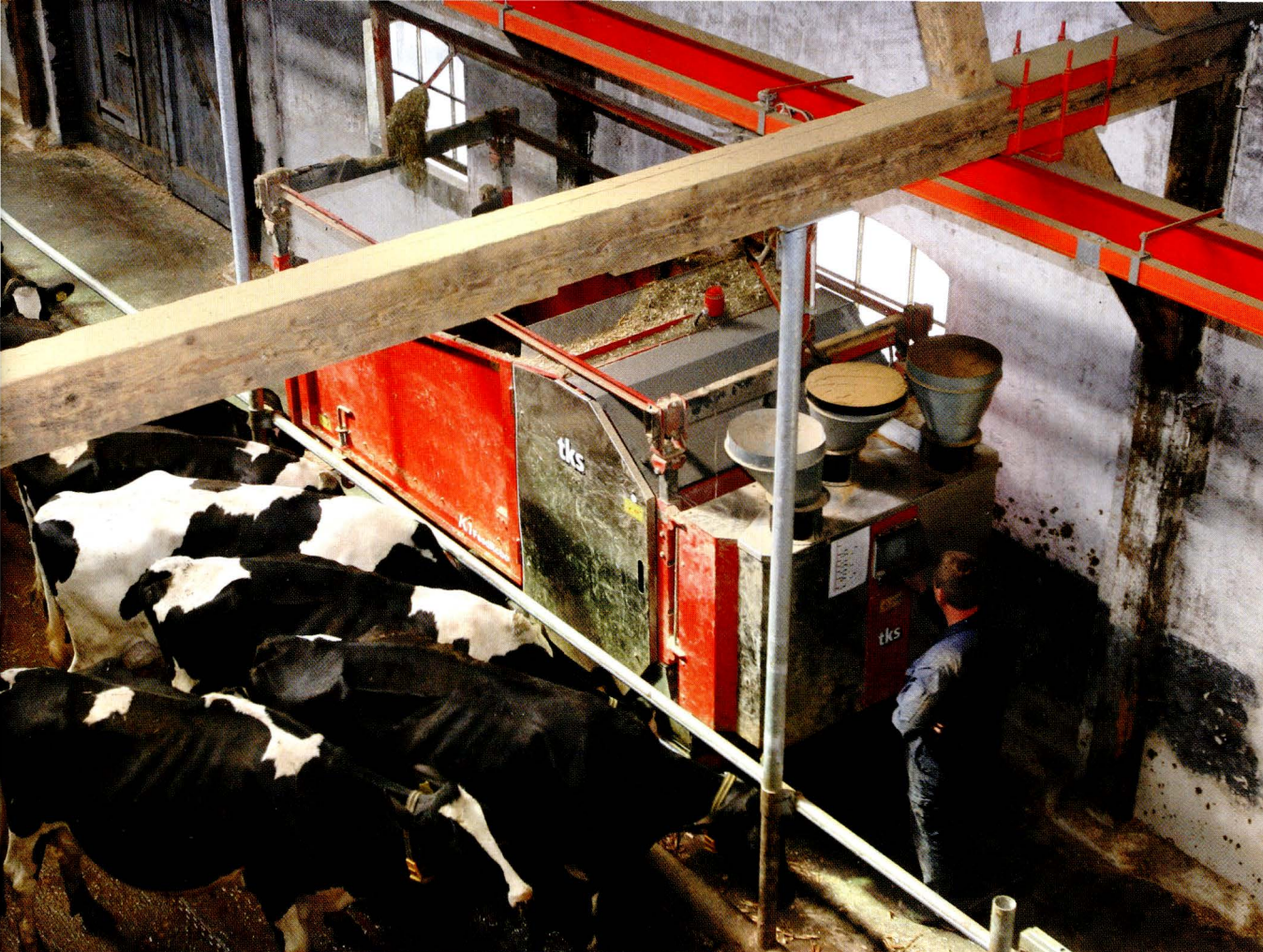
Voerrobots, stroverdelers en boxenstrooiers – de toenemende automatisering maakt dat er meer stroomrails in de stal komen. FOTO: PETER ROEK
