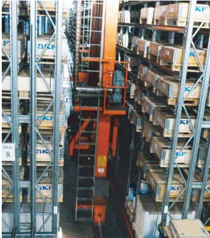
Omdat men voor de ombouw het automatisch magazijn niet wou stilleggen werden de werken ingepland in weekends in oktober en november.
